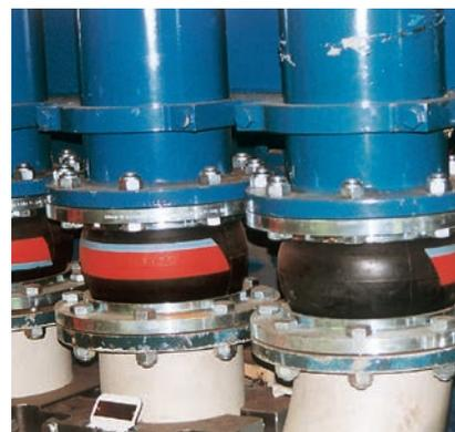
Type AS-1 STENFLEX® installé sur le circuit de refroidissement d'un moteur de bateau
